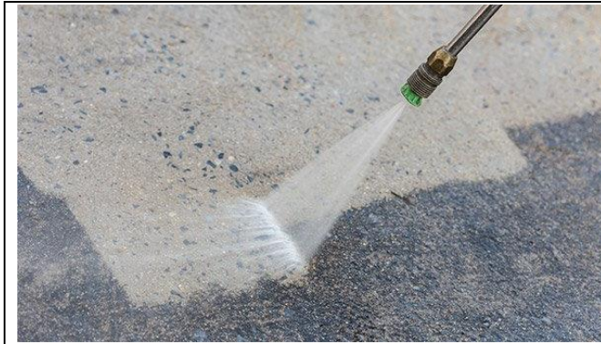
1. Vệ sinh bề mặt thi công
