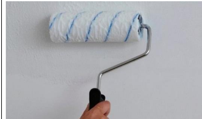
3. Thi công lớp lót Penetrating Primer
