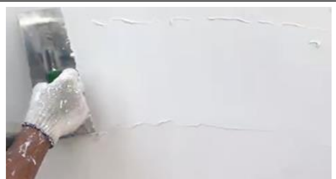
2. Xử lý bề mặt bằng Handycoat Exterior
