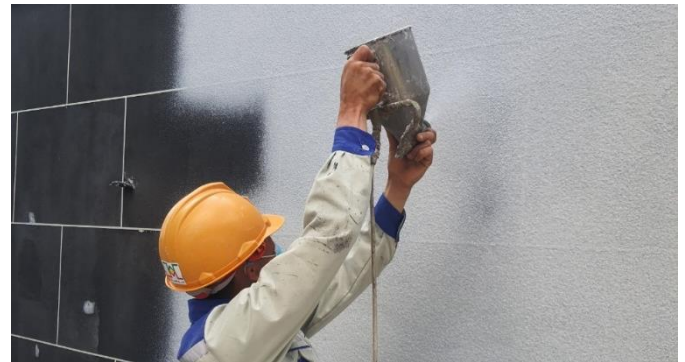
4. Thi công sơn đá Terralite Stone
